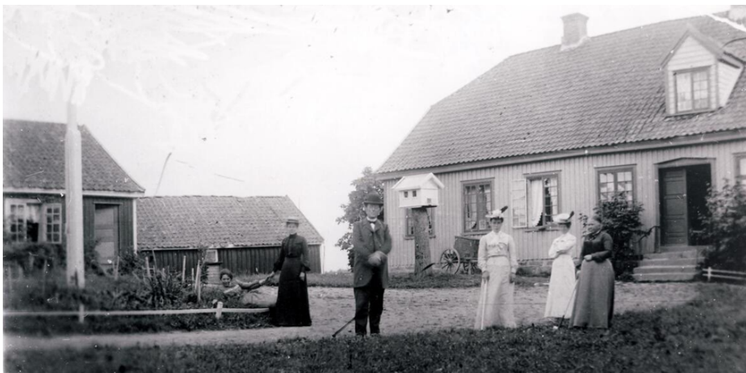
Figur 2: Fotografi av hovedbygningen og drengestua fra 1903
