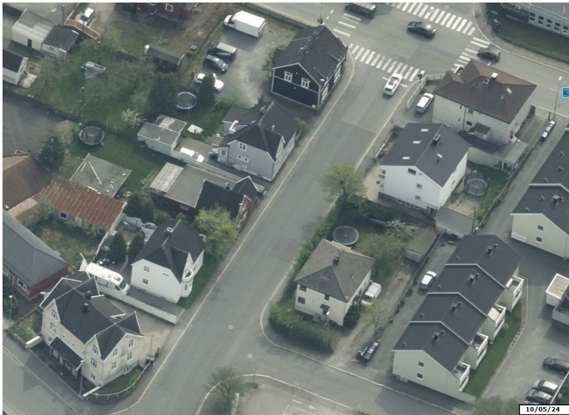
Figur 24: Oversiktsbilde Rosenkrantz gate nord (10.05.2024)
