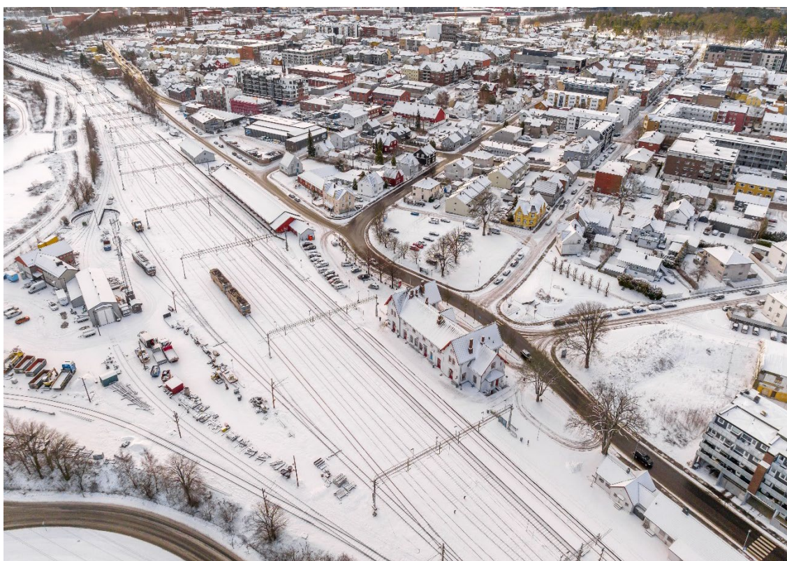
Figur 34: Oversiktsbilde over St. Nikolas gate og stasjonsområdet (dronebilde 04.02.2023)
